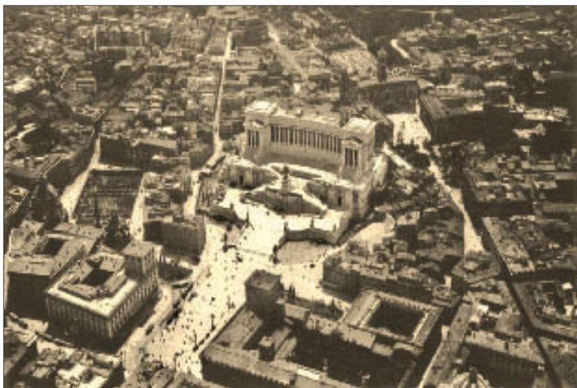
Piazza Venezia e i Fori durante i lavori
